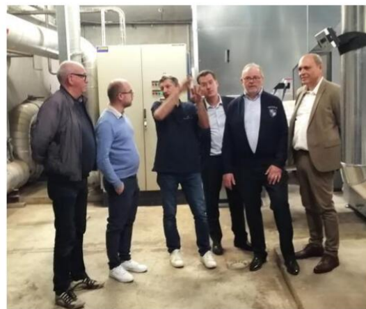
Les élus locaux et représentants de Haut-Bugey Énergie, qui investit dans la chaufferie hautevilloise, devant le nouveau matériel. Photo Guy Domain
