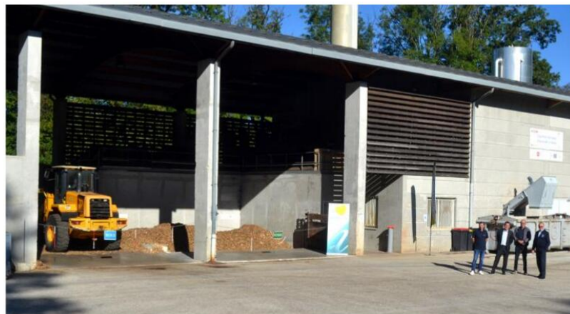
La chaufferie biomasse hautevilloise, pionnière dans la région, connaît une deuxième jeunesse et va étendre son réseau chaleur. Photo Guy Domain
